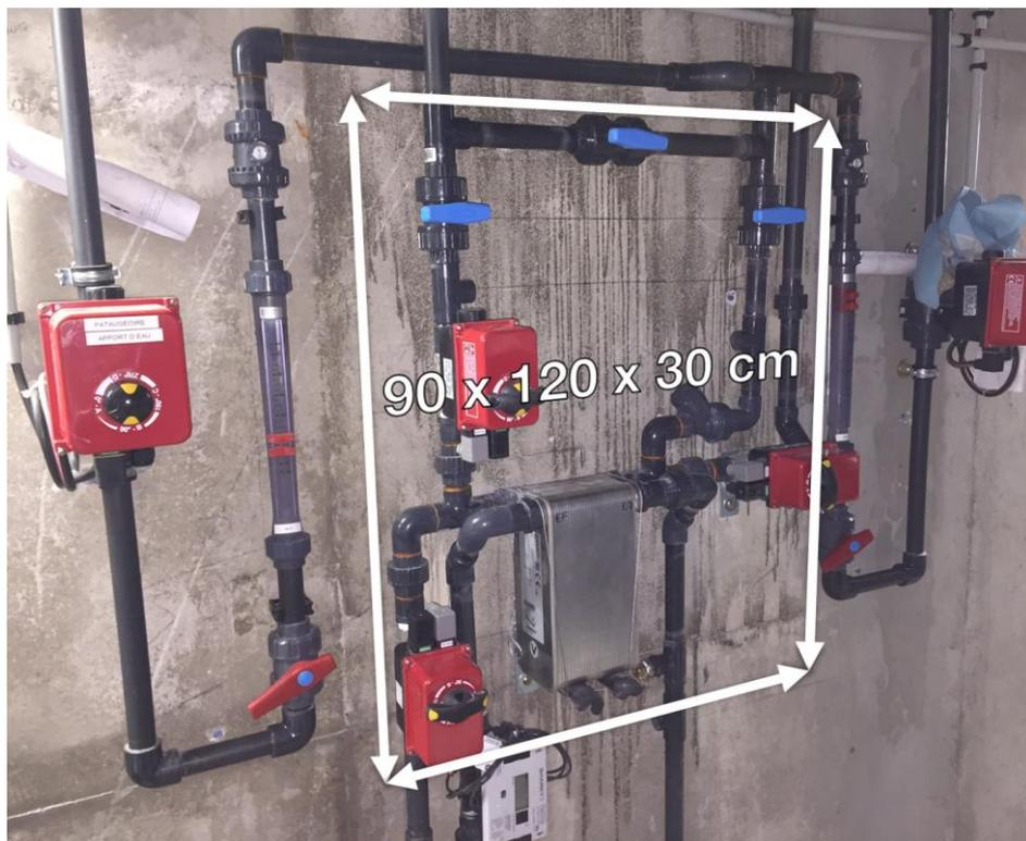
Ci à gauche : pour répondre à une contrainte de place, Obox P a été « reconstitué » sur le mur d'une coursive de la zone technique. Le tableau électrique d'Obox P est déporté 3 mètres plus loin.
